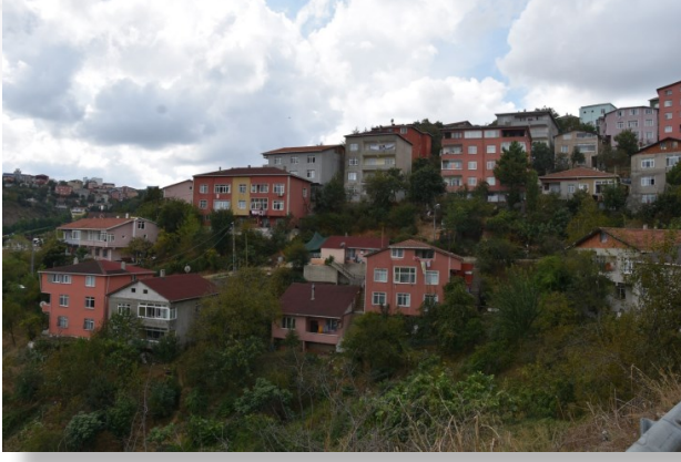
Şekil 36. Beykoz Çubuklu bölgesinde kentsel dönüşümün yapılması planlanan alanın mevcut görünümü
